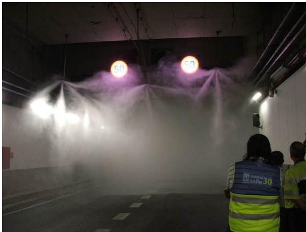
Abb. 1: Aktivierung einer Wassernebel-BBA in einem Tunnel der M30 in Madrid (Quelle: IFAB)
