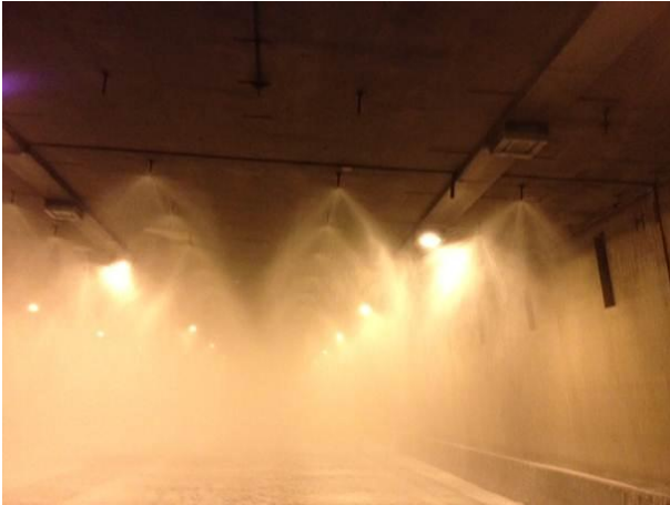
Abb. 2: Aktivierung einer Sprühflut-BBA im Mount Baker Tunnel (I-90) in Seattle (Quelle: IFAB)
